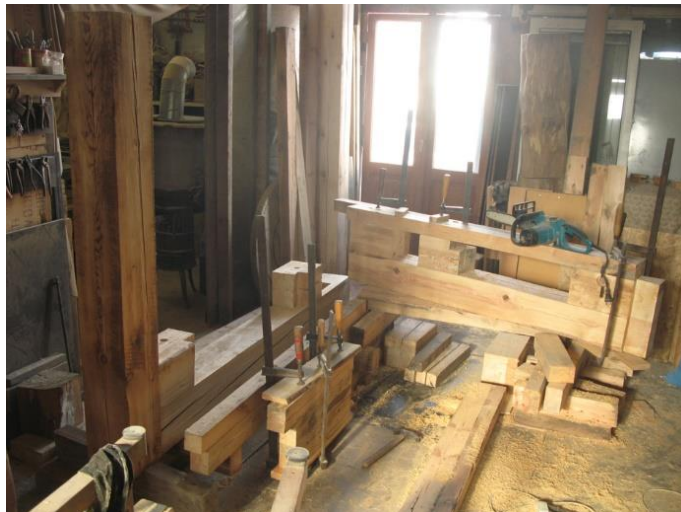
7. Klejenie elementów konstrukcyjnych i przygotowywanie połączeń.
