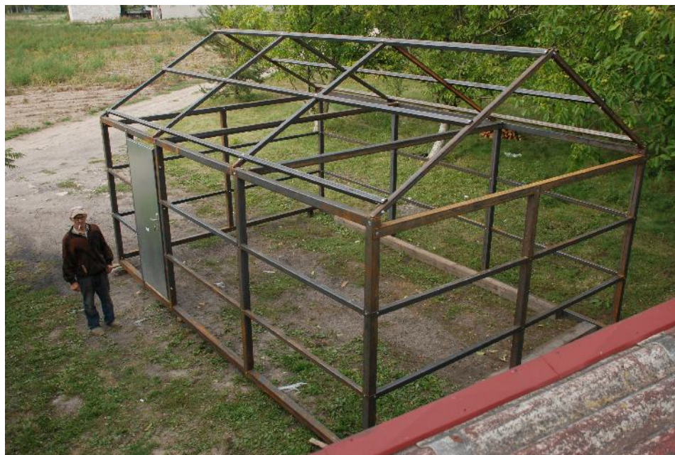
Metalowa konstrukcja zbudowana przez Stanisława Adamskiego i Adama Pestę, Kurówko 2015
