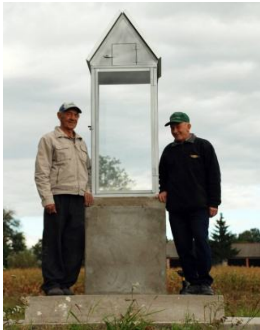
Prace nad budową Galerii Kapliczki
