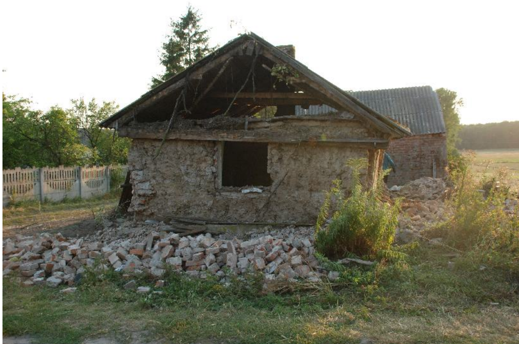
Rozbiórka domu w Kurówku, 2015
