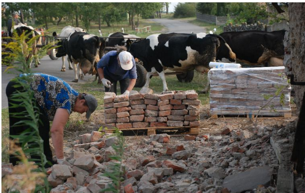
Rozbiórka domu w Kurówku, 2015
