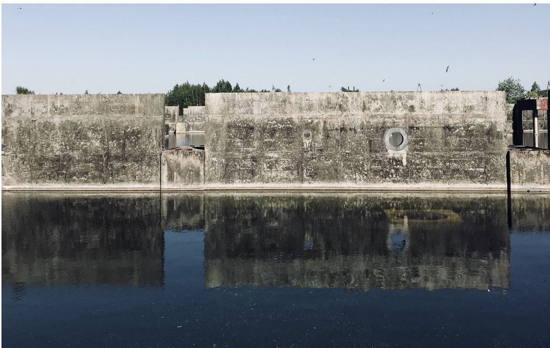
il. 38. Pozostałości zabudowań niezrealizowanej elektrowni atomowej w Żarnowcu.
