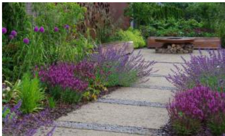
Ilustracja 61. Przepuszczalna nawierzchnia mineralna w ogrodzie przydomowym. Sierakowice. Projekt, realizacja oraz fot. A Hubeny-Żukowska
