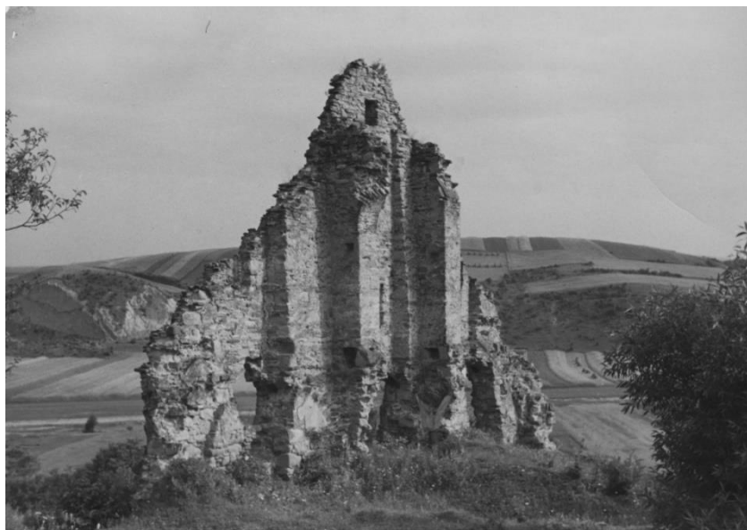
il. 18. Zdjęcie ściany szpitala
