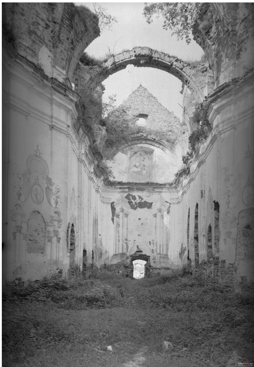
il. 48. Wnętrze kościoła, widok w stronę głównego ołtarza
