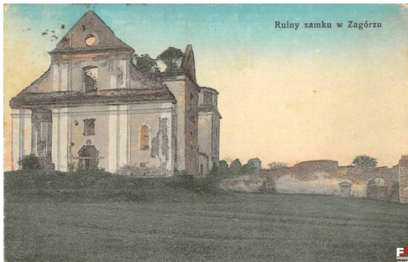
il. 20. Elewacja kościoła z około 1910 roku
