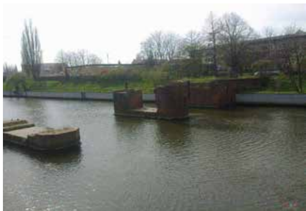
Widok na nieistniejący Most Rogoźników na Nowej Motławie
