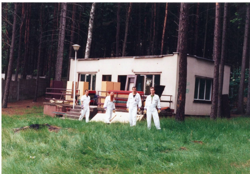
Ilustracja 14: C.U.K.T., urzędnicy C.U.K.T. na tle remontowanego domku turystycznego.
