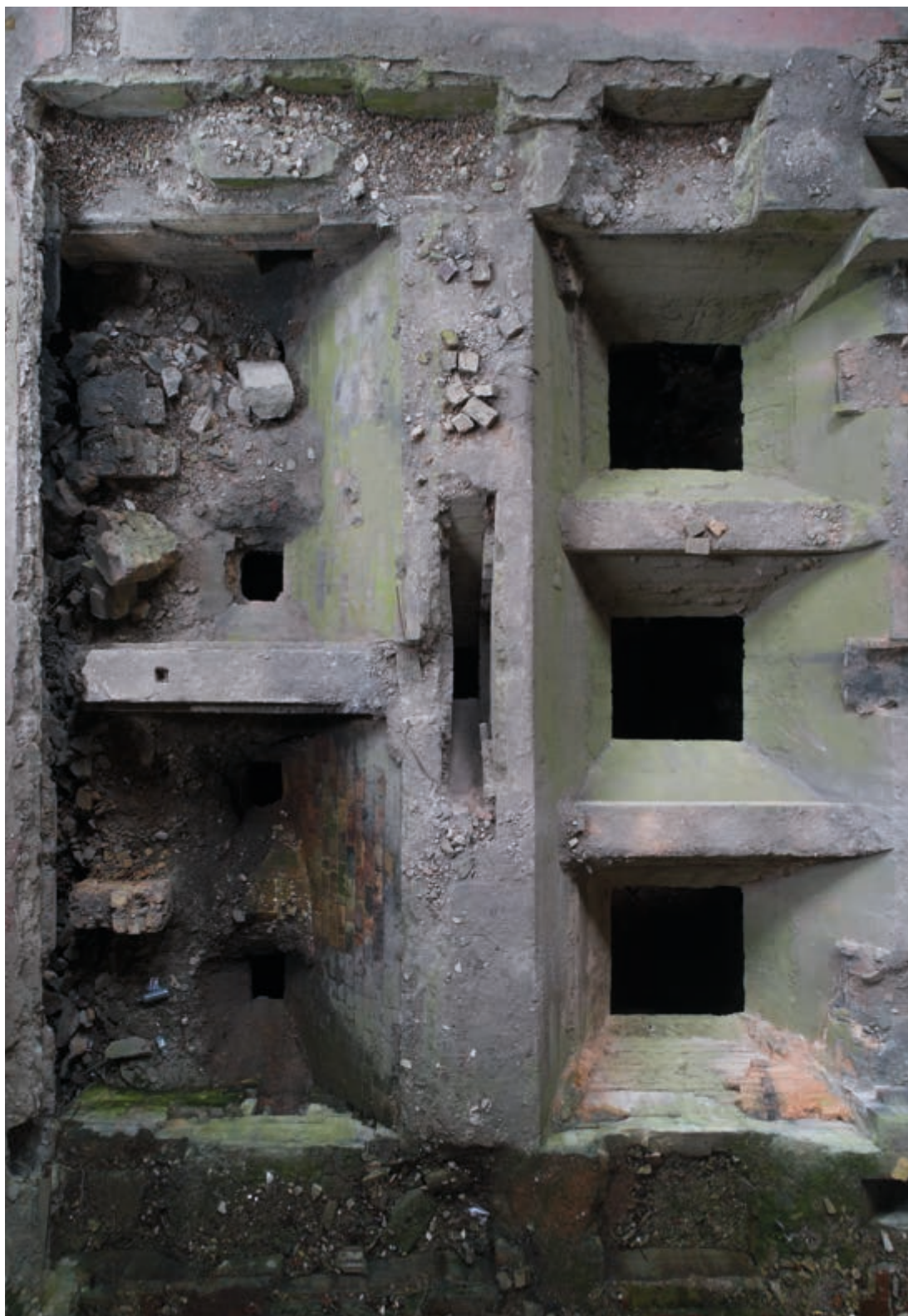
Fot. 18. Postfabrykat - strop elektrociepłowni fabryki nr I widziany kamerą drona: spojrzenie II Źródło: zbiory własne.
