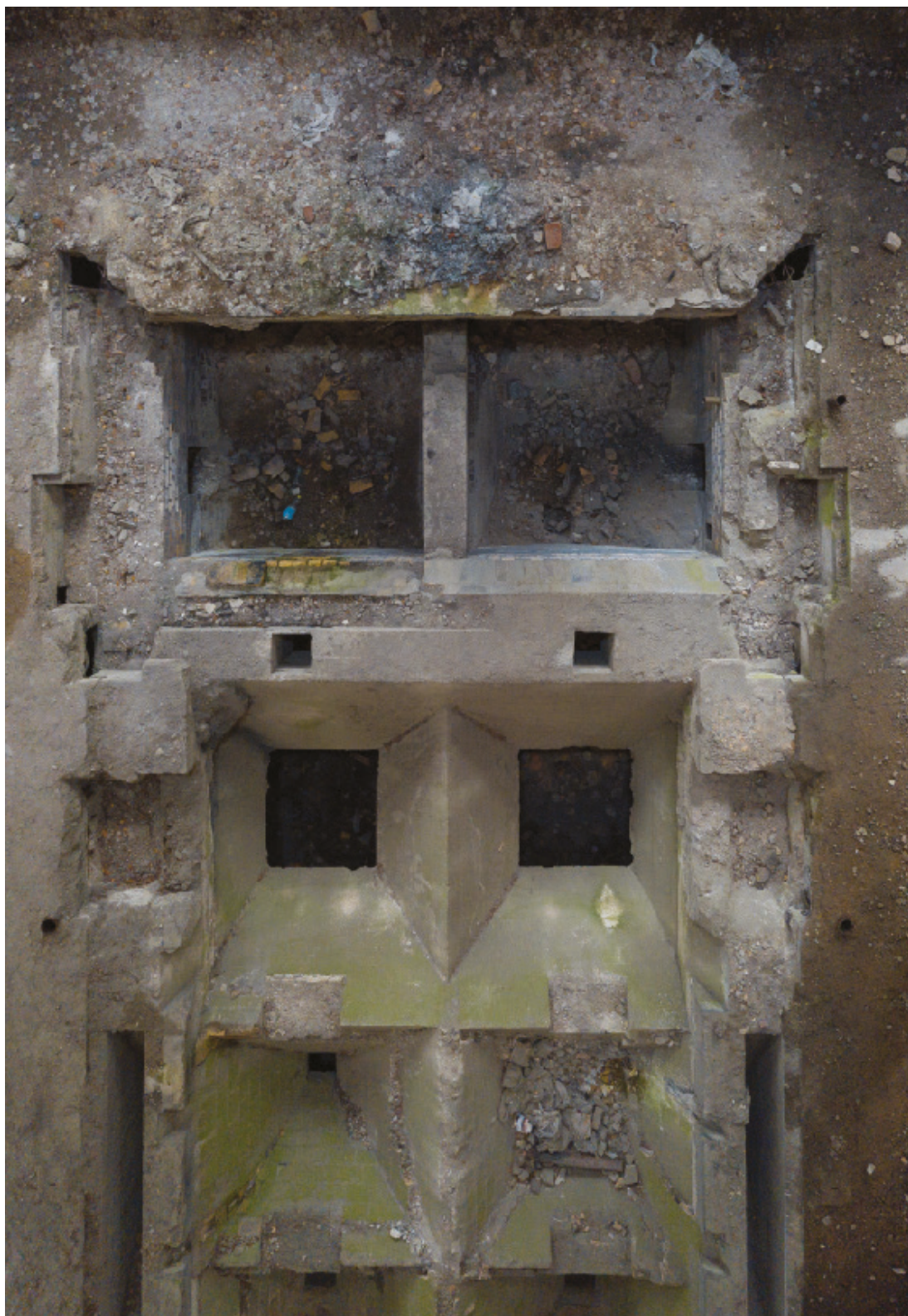
Fot. 19. Postfabrykat - strop elektrociepłowni fabryki nr II widziany kamerą drona: spojrzenie II Źródło: zbiory własne.
