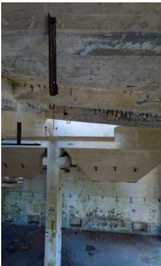
Fot. 25. Zsypy elektrociepłowni fabryki nr I widziane kamerą drona Źródło: zbiory własne.
