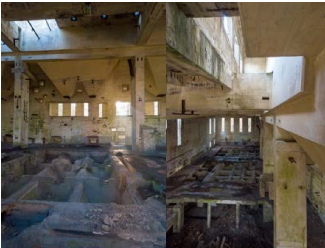
Fot. 21. Ściana dzieląca dwie sąsiadujące hale elektrociepłowni fabryki nr I, widziana kamerą drona Źródło: zbiory własne.
