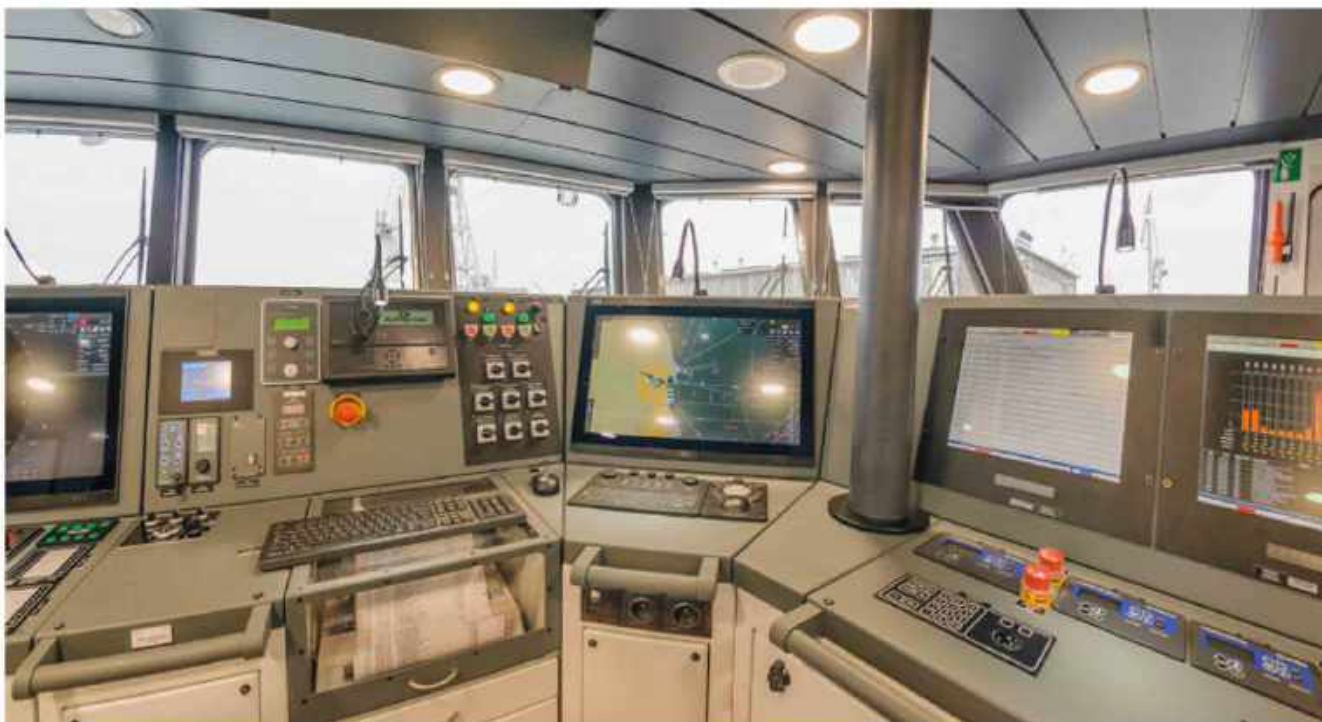
Detal konstrukcji pulpitu z charakterystycznymi podziałami na panele pozwalającymi na niezależny dostęp serwisowy do jego poszczególnych sekcji. fot. Dariusz Dyr
